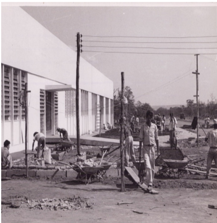
Construção do Instituto Nacional de Identificação / FOTO: Arquivo INI
